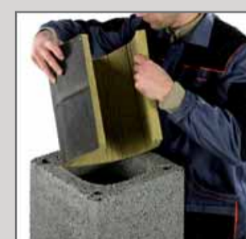
14. Вкласти мінеральне волокно до наступного пустотілого блоку.
