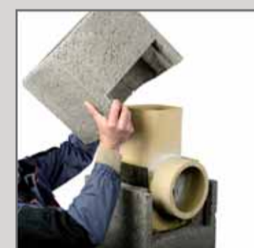
23. Розмістити пустотілий блок з наступною частиною вирізу на розчині.
