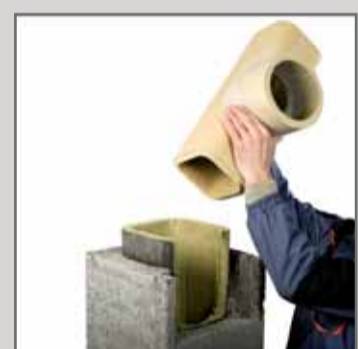
22. Приклеїти трійник (приєднання виходу печі).
