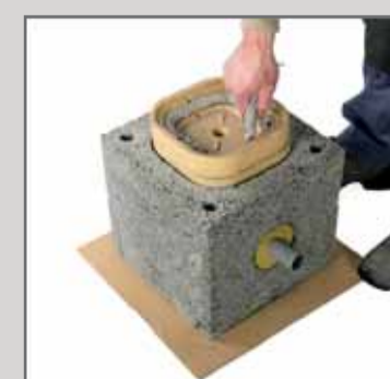
5. Накласти кислотостійку замазку на миску відведення конденсату.
