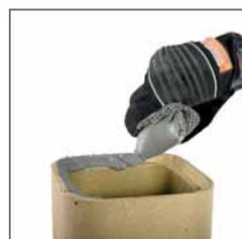
7. Нанести замазку на шпунтове з'єднання.
