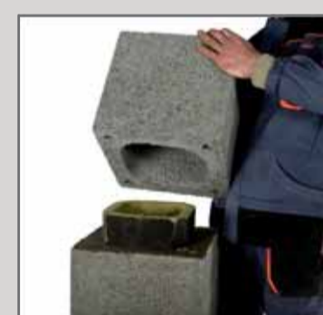
15. Розмістити на розчині наступний пустотілий блок.
