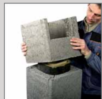
19. Пустотілий блок з вирізаним отвором на коліно димових газів поставити на розчині.
