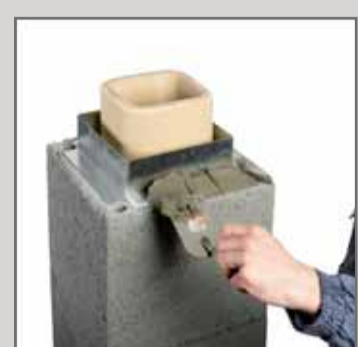
31. Розмістити незнімну опалубку, накласти будівельний розчин.
