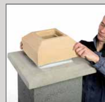
36. Приклеїти керамічну заслону виходу димоходу.
