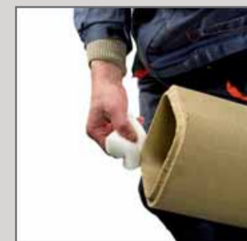
8. Очистити вологою губкою шпунтове з'єднання.
