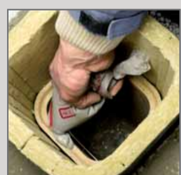
16. Накласти кислотостійку замазку.
