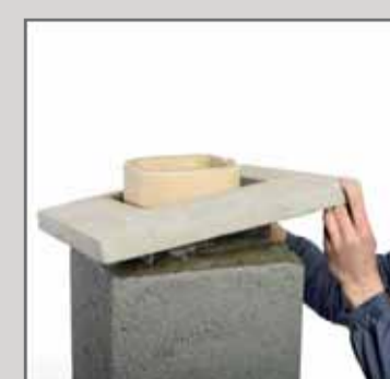
32. Розмістити накривну бетонну плиту на розчині.
