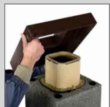
28. Покласти накривну цементно-волоконну плиту.
