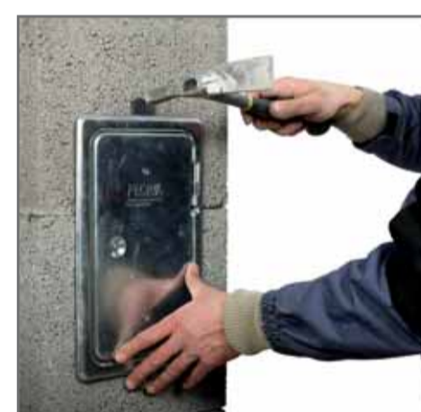
Зовнішні дверцята прочистки кріпляться за допомогою покрівельних цвяхів.
