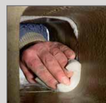
17. Усунути надмір замазки з внутрішньої сторони шва за допомогою вологої губки.
