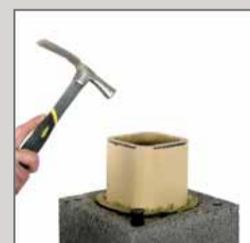
21. Вбити закріпи у наріжні отвори пустотілого блоку.
