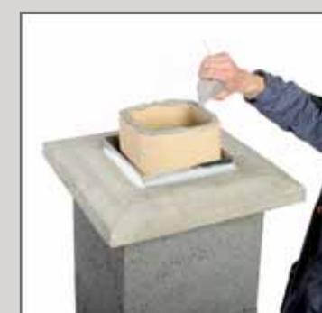
35. Накласти замазку на підрізану керамічну трубу.
