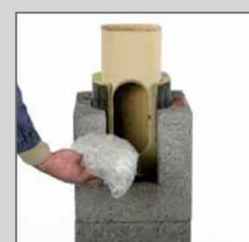
11. До середини очисного люка покласти фольгу або листок паперу для захисту від розчину.
