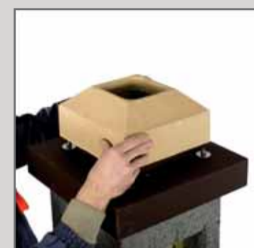
30. Накласти замазку на зрізану трубу і приклеїти керамічне облицювання виходу димоходу.
