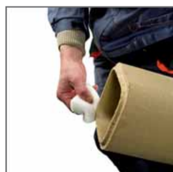
6. Очистити вологою губкою шпунтове з'єднання кераміки.
