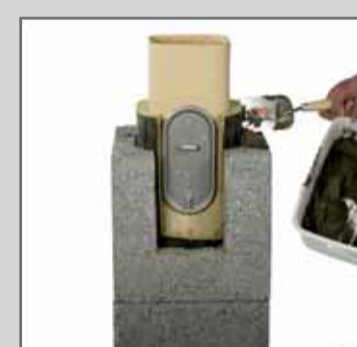
12. Накласти будівельний розчин на пустотілий блок.
