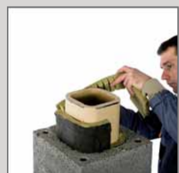
25. Відрізати надмір волокна за останнім пустотілим блоком.
