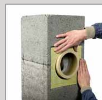
24. У вирізаний пустотілий блок вставити плиту з мінерального волокна.
