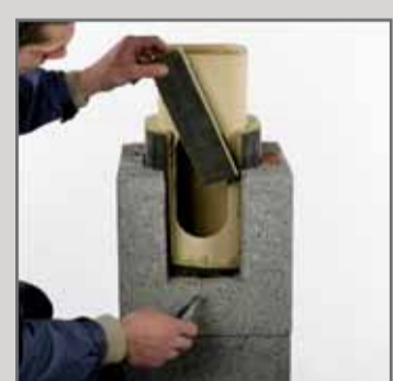
10. Підрізати плиту з мінерального волокна до розмірів отвору в пустотілому блоці.
