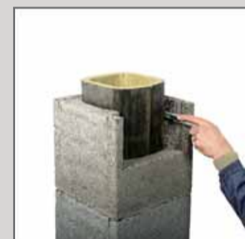
21. Підрізати волокно до підготованого отвору.
