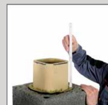
26. Відміряти потрібну довжину керамічної труби так, щоб керамічне облицювання виходу димоходу було на 1 см вище накривної плити.
