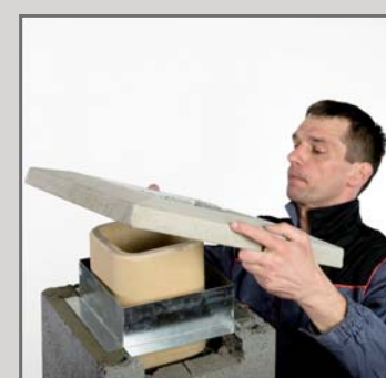
30. Накласти бетонну накривну плиту.
