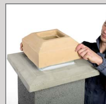
33. Приклеїти керамічну заслонку виходу димоходу.
