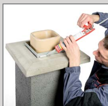
31. Простір між опалубкою і плитою ущільнити покрівельним силіконом
