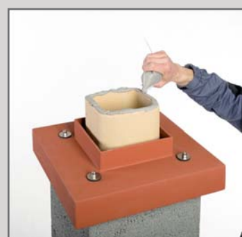
26. Приклеїти цементно-волоконну плиту за допомогою системи кріплення. Накласти замазку на підрізану трубу.
