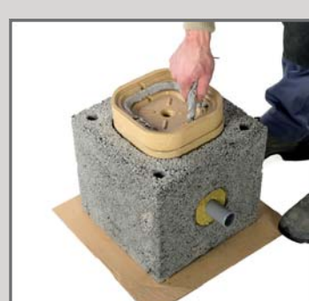
5. Накласти кислотостійку замазку на тарілку відведення конденсату.
