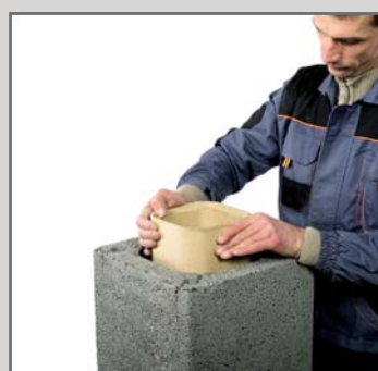
19. Дотиснути трубу, щоб витиснути надмір замазки, усунути його волого губкою.
