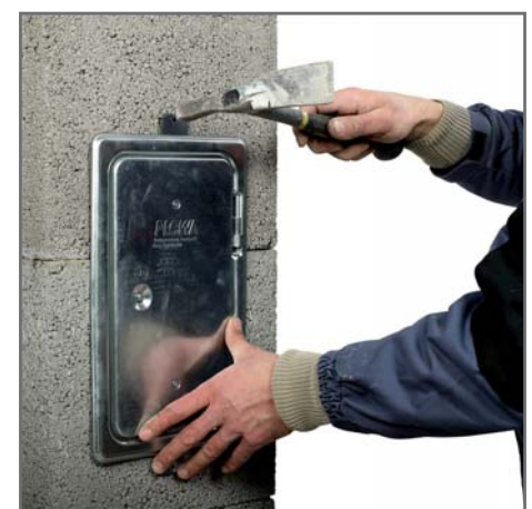
Зовнішні дверцяла прочистки кріпляться за допомогою цвяхів (покрівельних цвяхів).
