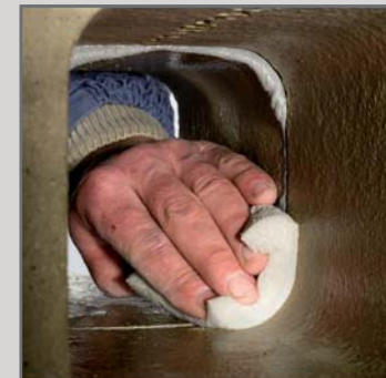
12. Усунути надмір замазки з внутрішнього боку за допомогою вологої губки.
