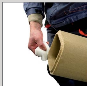
7. Очистити шпунтове з'єднання вологою губкою.
