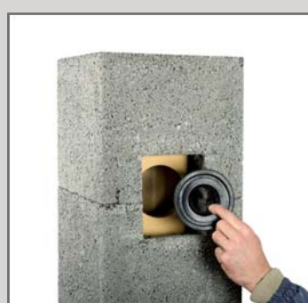
22. Встановити приєднувальні прокладки LAS в кераміці.
