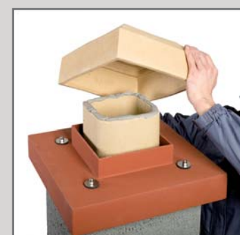
27. Приклеїти керамічне облицювання виходу комину, воно повинно знаходитись на 1 см вище плити.
