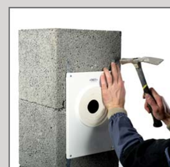
24. Прикріпити панель до пустотілого блоку цвяхами (покрівельними цвяхами)
