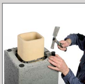
25. Відміряти потрібну довжину керамічної труби (приблизно 16 см) від останнього пустотілого блоку. При потребі зменшити трубу використовуючи кутову шліфувальну машину. Вбити закрепи у наріжні отвори пустотілого отвору.
