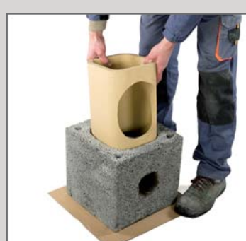
1. На шар ізоляції встановити пустотілий блок з вирізаним отвором на відведення конденсату, установити в ньому цокольную трубу.
