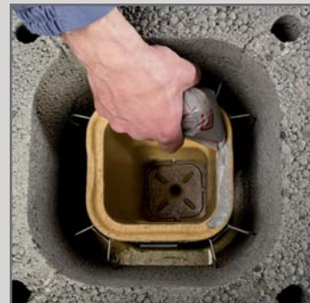
11. Накласти кислотостійку замазку.
