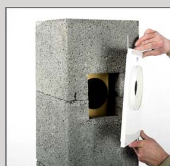
23. Відцентрувати панель з під'єднанням в кераміці.
