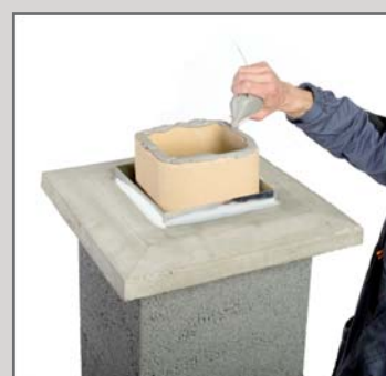
32. Накласти замазку на підрізану керамічну трубу.
